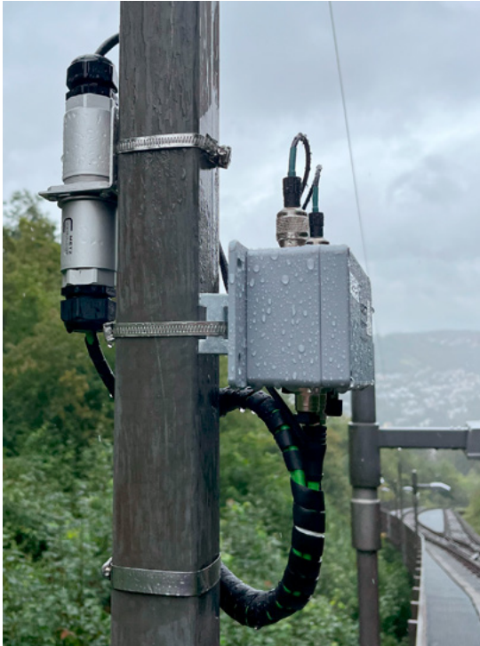
Befestigungsmast mit Schutzgehäusen MCO IP69k
